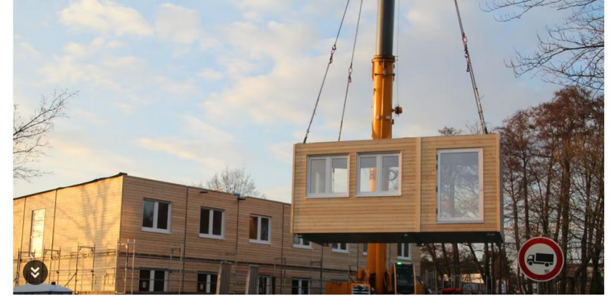
Der Aufenthaltsraum schwebt in der Luft: Mit dem Kran haben Marco Lepper und sein Team am Montag (12. Februar) 17 von 19 Modulen auf dem Jahnplatz in Enger an Ort und Stelle gebracht. Die 20 Wohnräume für Flüchtlinge sollen in etwa sechs Wochen bezugsfertig sein. Foto: Christina Bode
