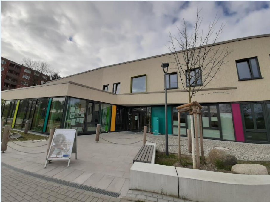
Kita Lotte Lemke mit Familienzentrum und Außenanlage
