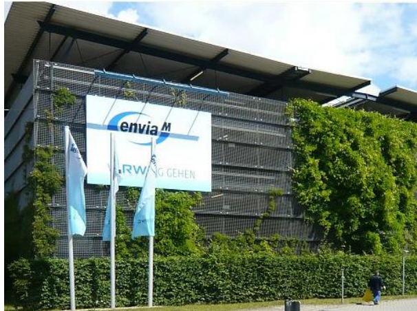
Foto 3: Beispiel einer bodengebundenen Fassadenbegrünung, verschiedene Kletterpflanzen an einem Parkhaus (FASSADENGRÜN E.K. 2019)
