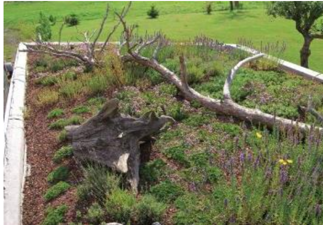
Foto 7: Beispiel einer extensiven Dachbegrünung mit Tot- holz
