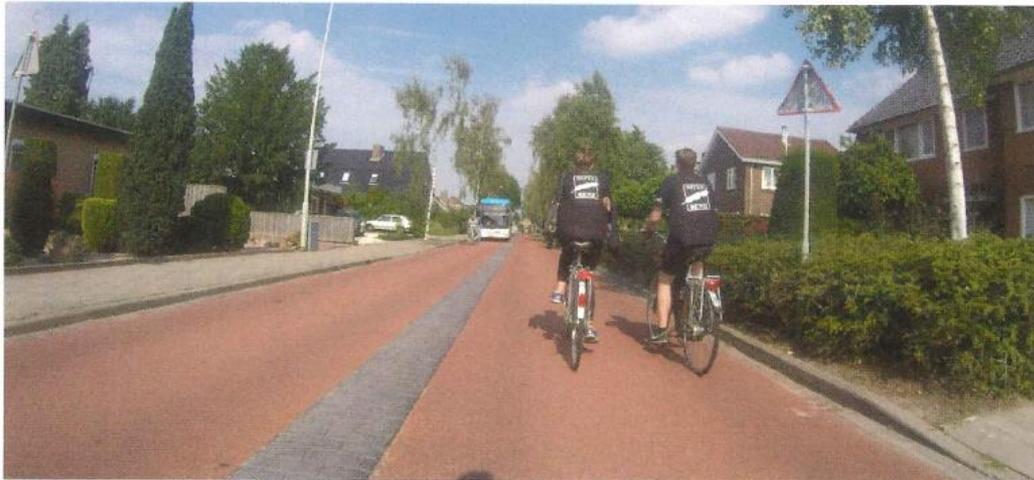
Abb. 64: Der aufgepflasterte Mittelstreifen senkt die Kfz-Geschwindigkeiten bei breiteren Fahrbahnquerschnitten und macht für Radfahrer das Nebeneinanderfahren attraktiv.
