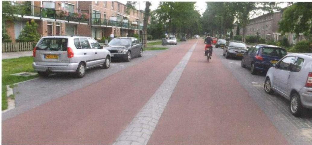
Abb. 65: Auch bei längeren geraden Abschnitten hat Profil 3 Vorteile, denn der Mittelstreifen engt die Fahrbahn optisch ein. In der Folge wird langsamer gefahren.
