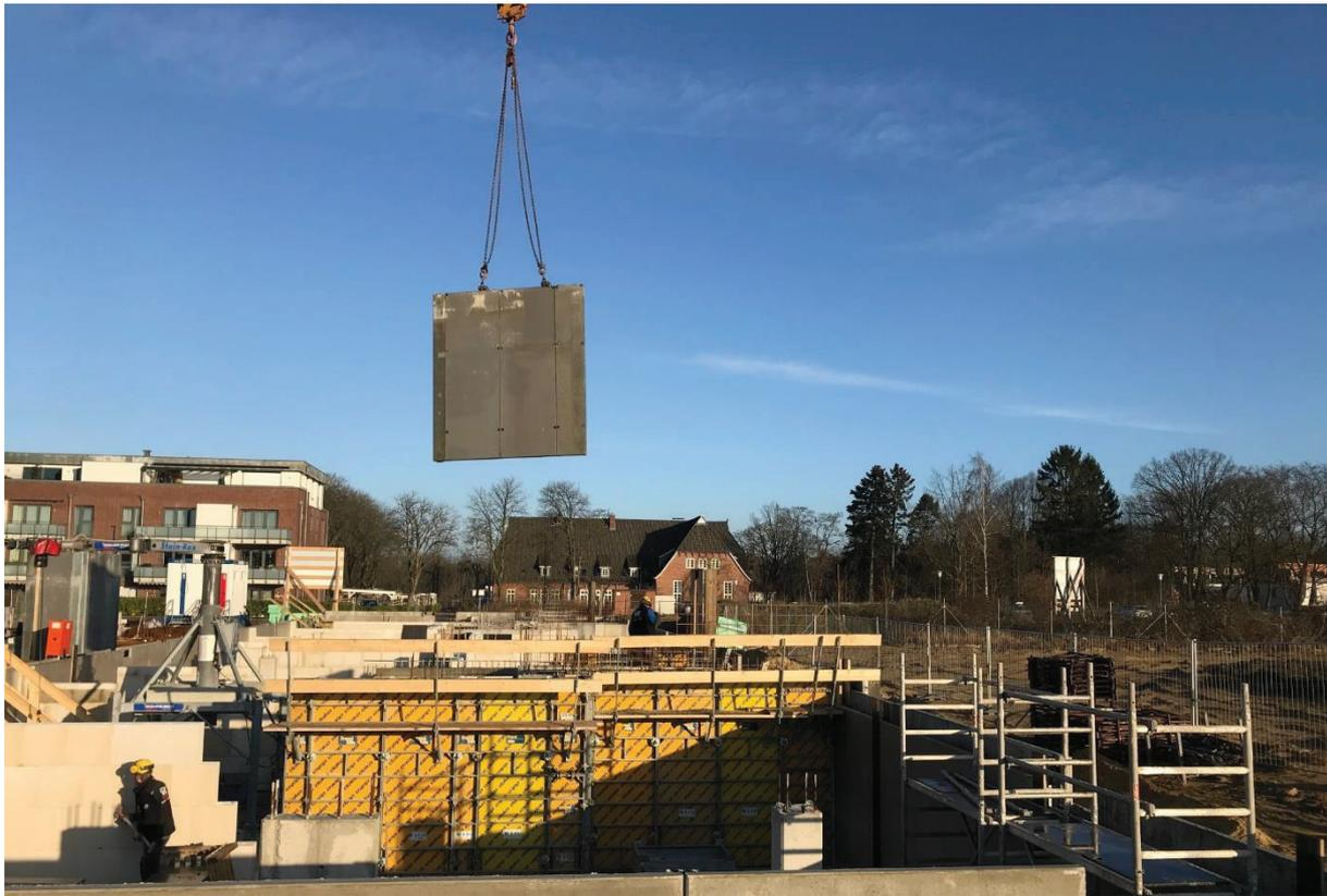
Montage Fertigteilwände im Keller I. Bauabschnitt, Dezember 2019
