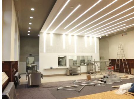
Gymnastikraum wird zur Mensa umgebaut
