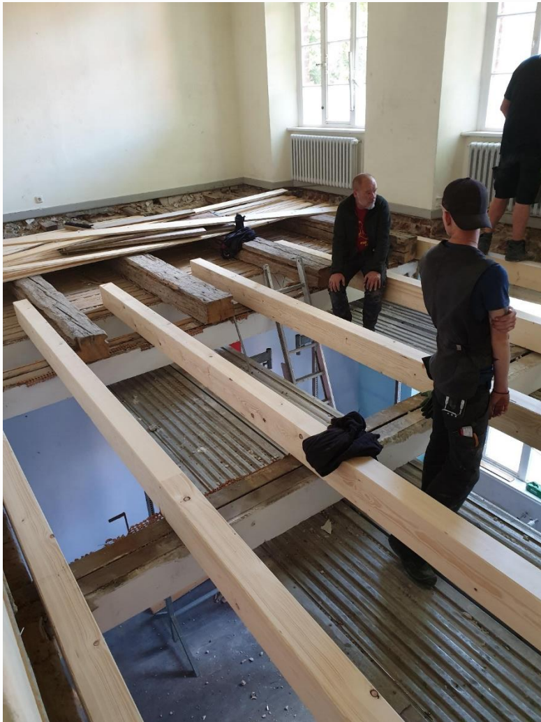
Deckeneinbau im September 2019
