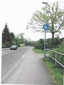
Brückensteig Richtung Ortsmitte Ochtmissen
