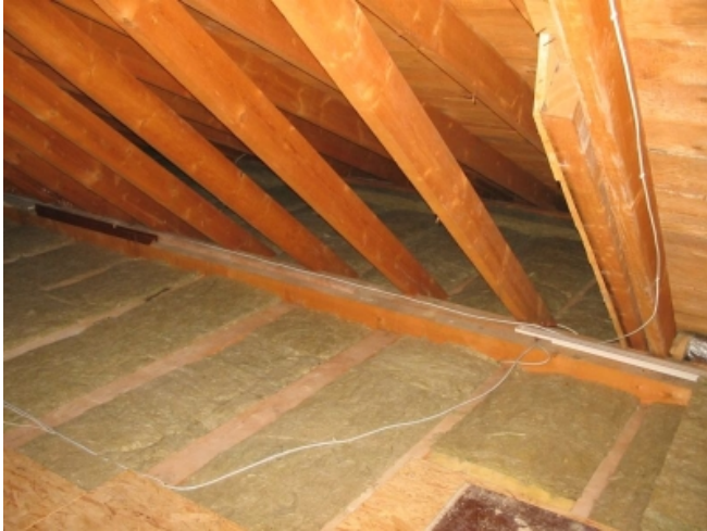
Dämmung oberste Geschossdecke
