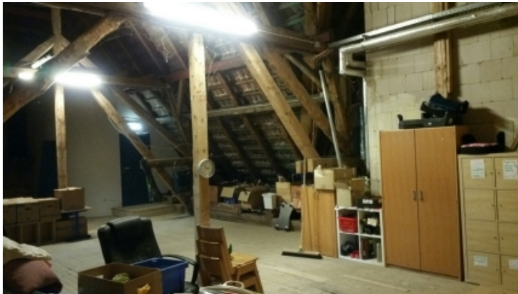
Innenansicht Gebäude Jugendzentrum Kaltenmoor
