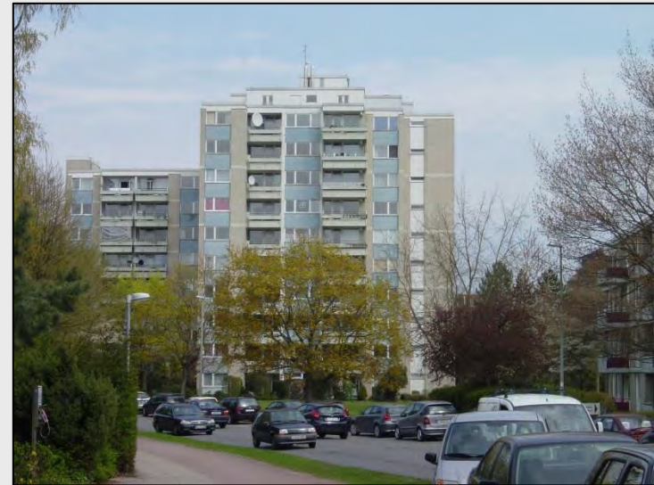
Sanierungsgebiet „Am Weißen Turm“ Programmaufnahme 07/2015
