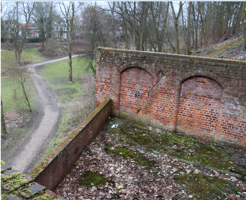
Fotoaufnahme Balkon Brückenkopf heute
