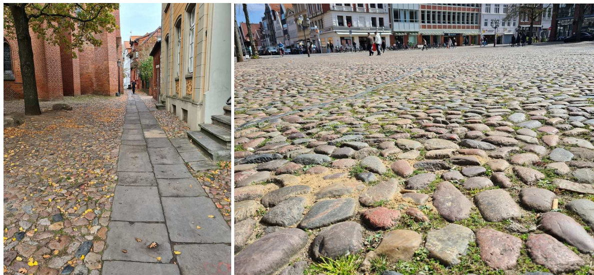
Abb. 31: Pflaster mit hohem Fugenanteil
