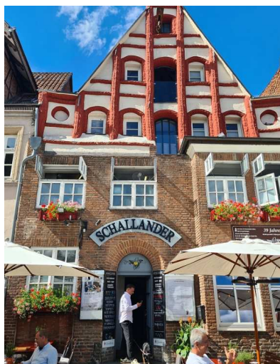
Vorsatzfassade mit Klinkerriemchen
