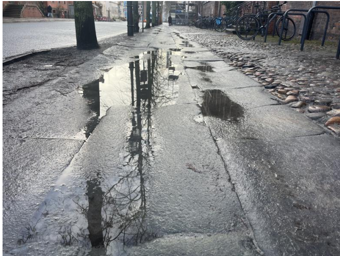
Straßenschäden, Versackungen und Pfützen stellen Hindernisse dar...
