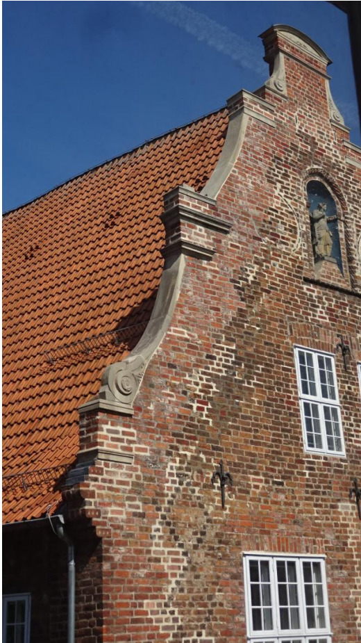
Foto: sanierter Zustand
