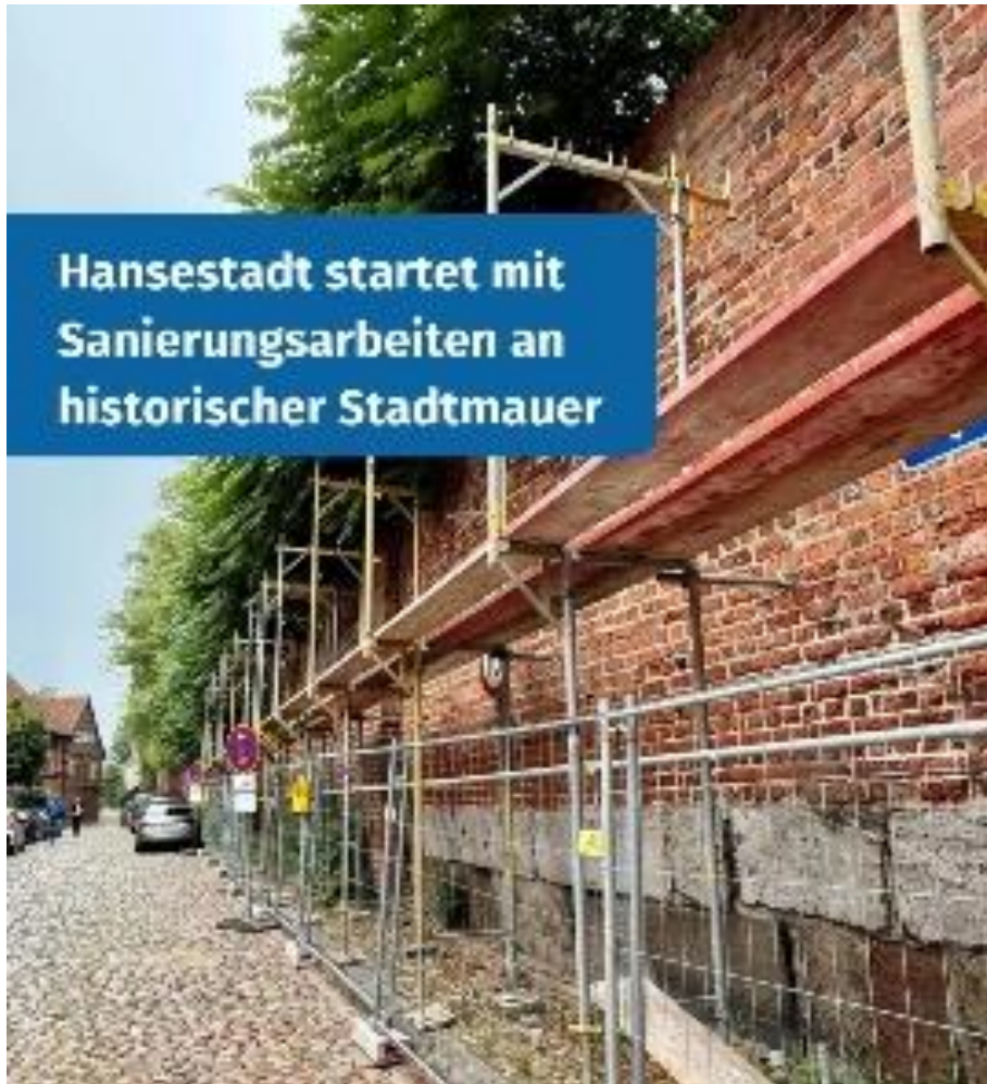
Foto: abgängige Ziegelflächen an der Stadtmauer
