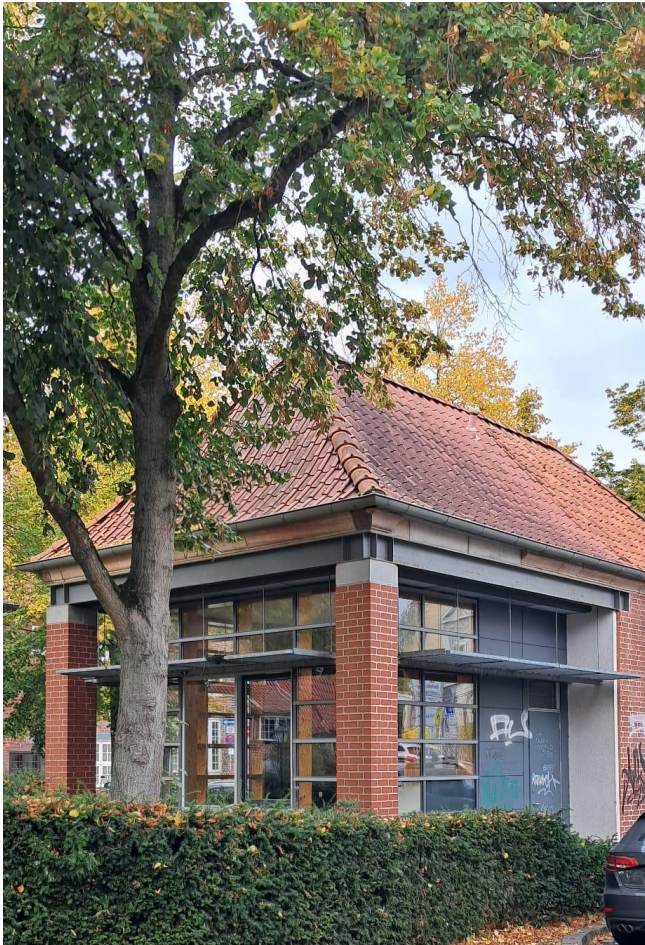
Foto: Pavillon Am Werder
