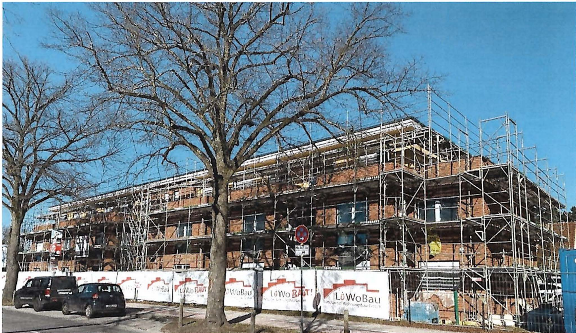
Neubau 20 geförderte Wohnungen Akazienweg 10 (Foto: LüWoBau)
